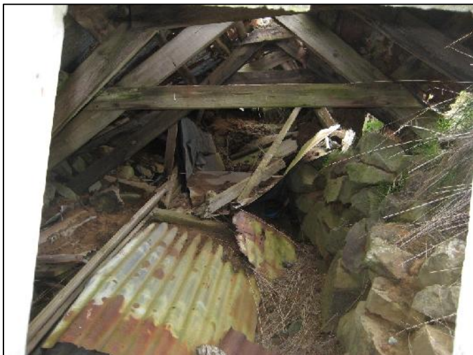
Hesthúsið horft inn (til suðurs)
