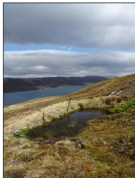
Stífla BO-146:008, horft til austurs
