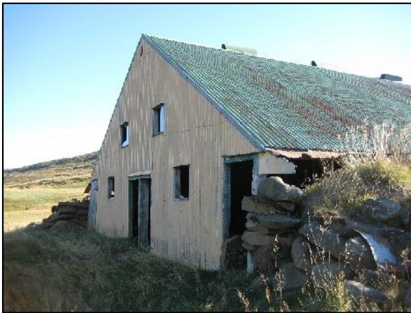
Nýju húsin BO-144:042, horft til austurs
