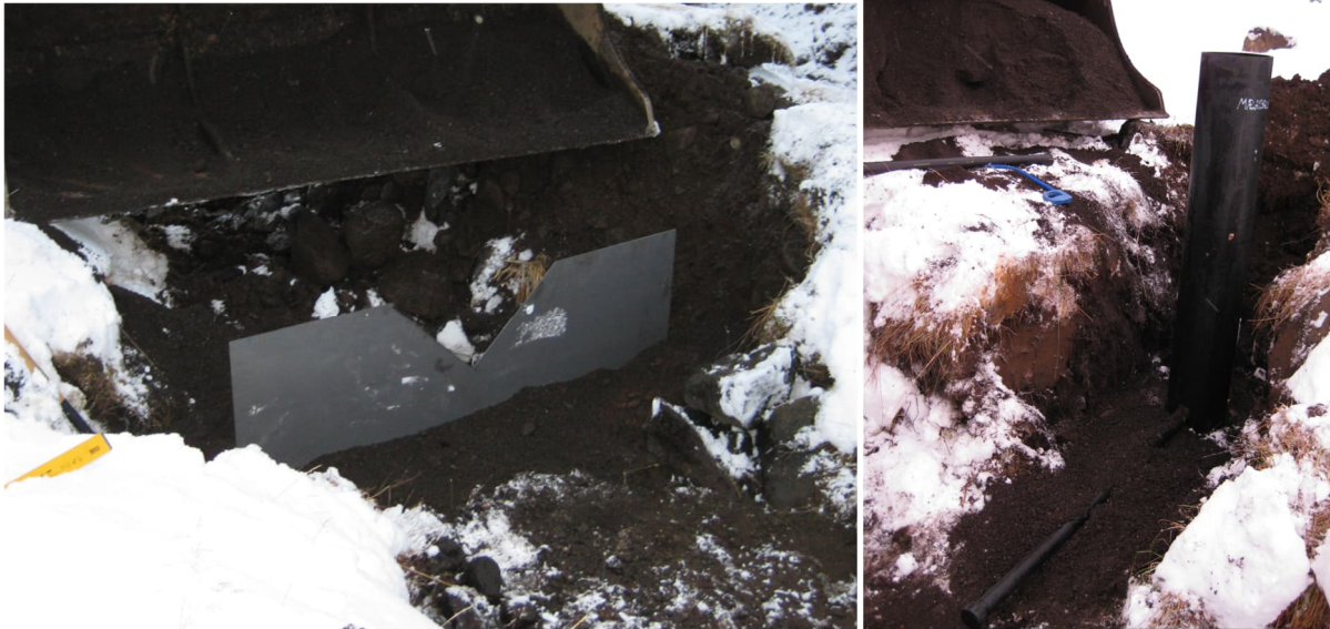
Mynd 12 Vinstri: Grafið fyrir og fyllt að sambærilegu mæliyfirfalli og því sem lagt er til hér. Hægri: Grafið fyrir mælibrunni í bakka. Samband fæst við vatnshæð í tjörninni með röri sem tengist brunninum.
