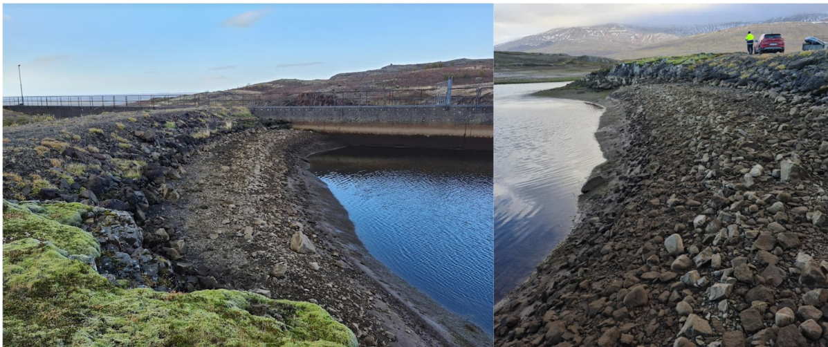
Mynd 2 Hér má sjá bermu stíflunnar vatnsmegin. Myndir teknar þegar lækkað var í lóni og gryfjur í set teknar í október 2021. Sjá má að á bermu er nokkuð um grjót en nærri vatnsborði er set. Vinstri: horft til norð-vesturs, hægri: horft til suð-austurs (myndir: Unnar Númi Almarsson).
