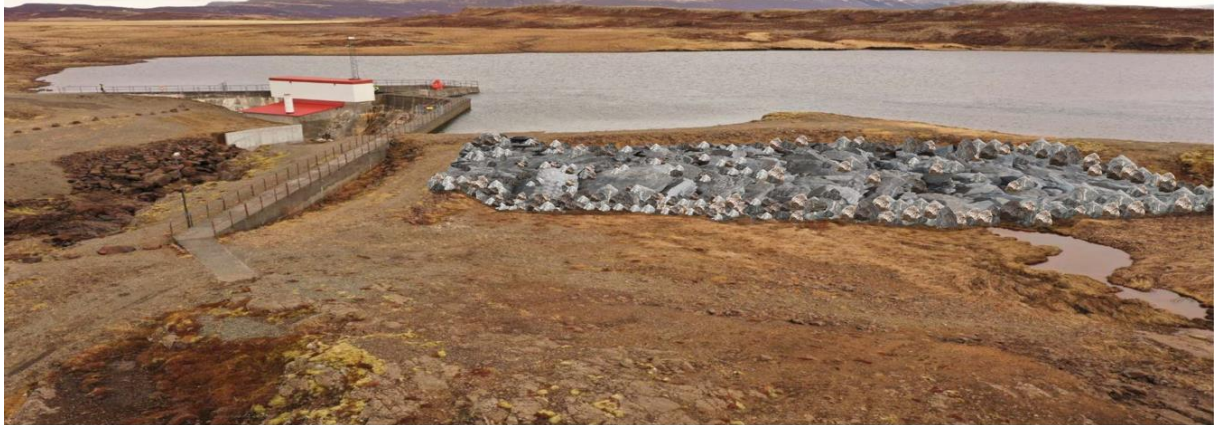
Mynd 3: Styrking jarðvegsstíflu, séð frá suðri til norðurs
