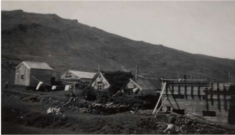
Mynd 13. Gamli torfbærinn á bæjarhólnum í Vatnshorni árið 1937 þegar nústandandi íbúðarhús er í byggingu.
